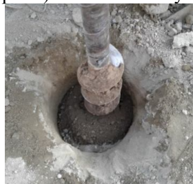
1-расм. Диаметри 500 мм, чуқурлиги 1000 мм бўлган скважина ва ушбу скважина марказидан диаметри 250 мм ли скважина бурғуланиши.
