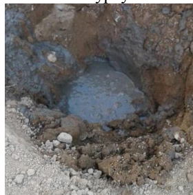
3-расм. Цемент-қум қоришмаси билан тўлдирилган скважина.
